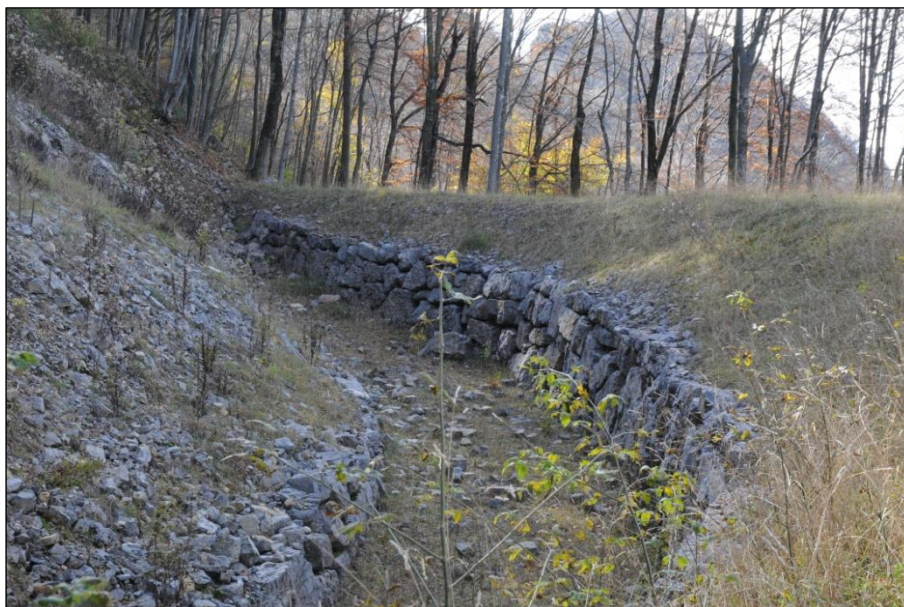
Figura 6 - Vallo paramassi sul pendio
